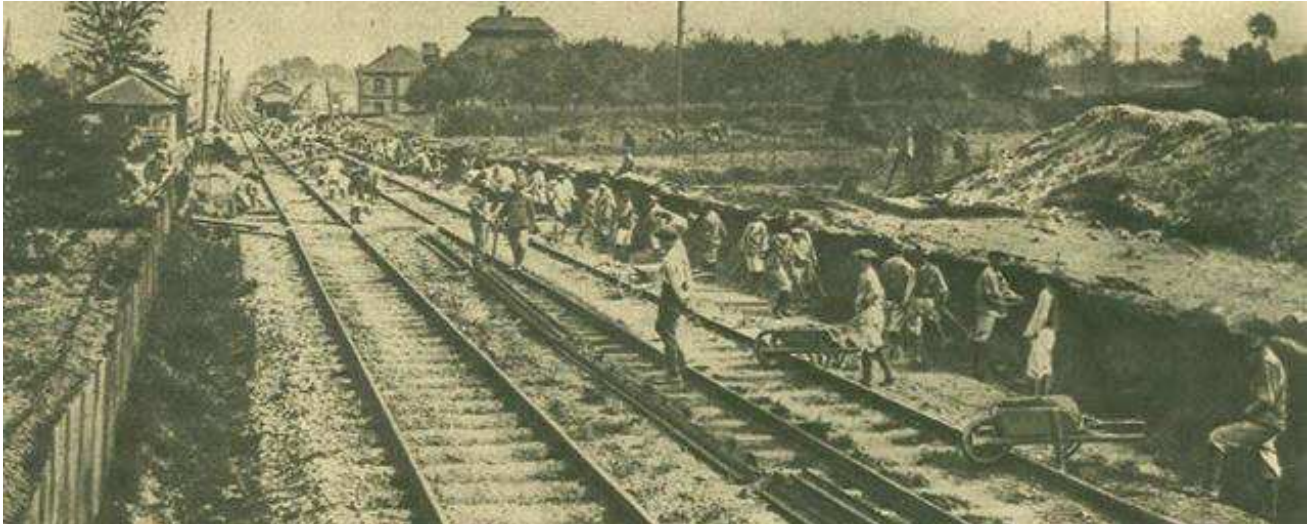
Réparation de voies ferrées
